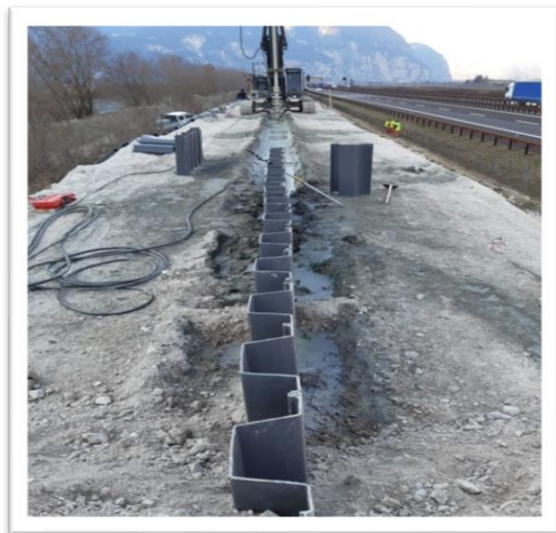
Rome (Italie) – 11000 m 2 – mur d'étanchéité (cut-off wall)
