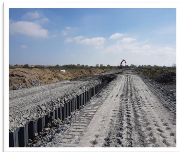
Rome (Italie) – 11000 m 2 – mur d'étanchéité (cut-off wall)
